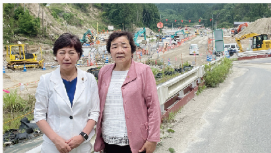
中嶋玲子県議と、朝倉の災害復旧工事の現場にて
